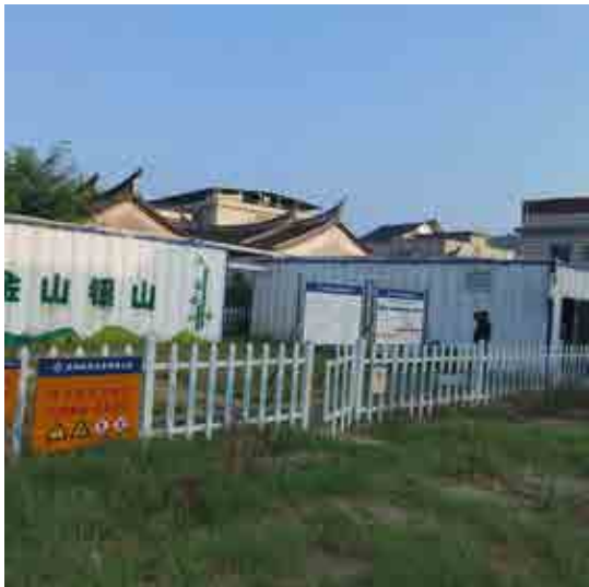
一体化污水处理设施
